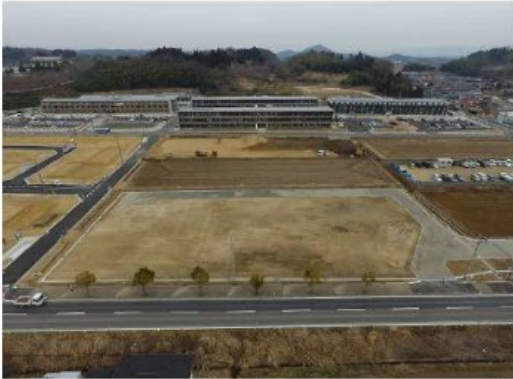
H29(2019).1 本体工事着工時
